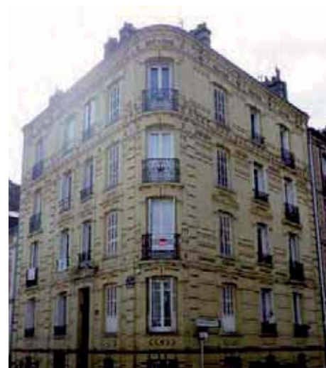
● Immeuble réhabilité - Le Havre centre ancien
